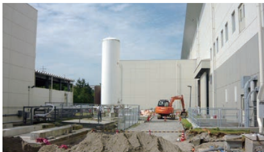
(b) Foundation work (Aug.)
