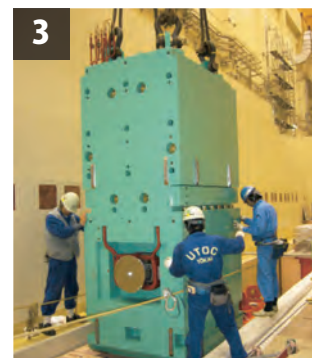
超高耐放射線電磁石 高エネルギーの陽子を標的に向かって 撃ち込むための電磁石。陽子が放つ 強い放射線を遮蔽するために鉄で囲 われています。
