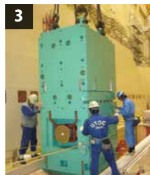
3 超高耐放射線電磁石 高エネルギーの陽子を標的に向かって撃ち込むための電磁石。陽子が放つ強い放射線を遮蔽するために鉄で囲われています。
